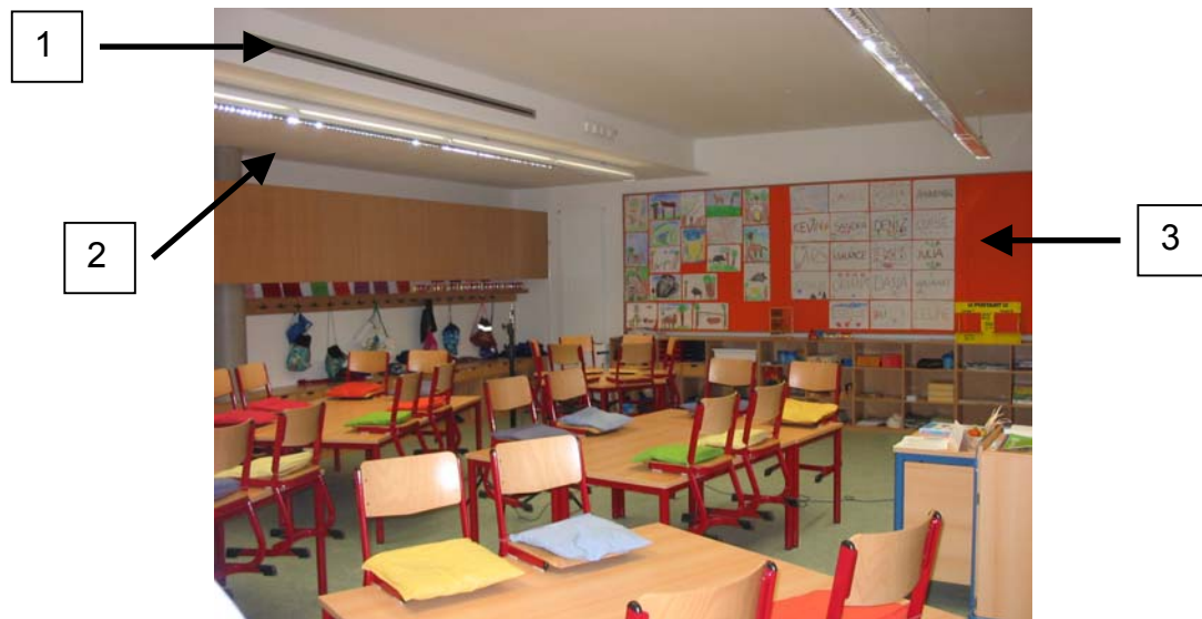
Bild 4: Unterrichtsraum der Grundschule (1) Deckenkoffer für Lüftungsleitungen mit Schlitzauslässen (2) raumakustische Maßnahmen an Deckenkoffer Gipskartonlochplatten (3) raumakustische Maßnahmen an Rückwand Absorberelement als Pinnwand
