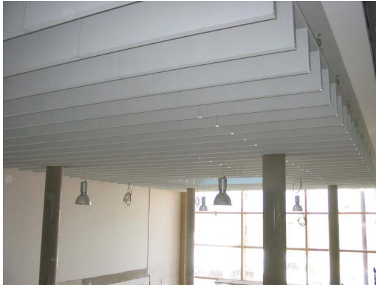
Bild 3: Baffeldecke mit vertikal angeordneten Schallabsorbern – Ausführung im Foyer der Grundschule
